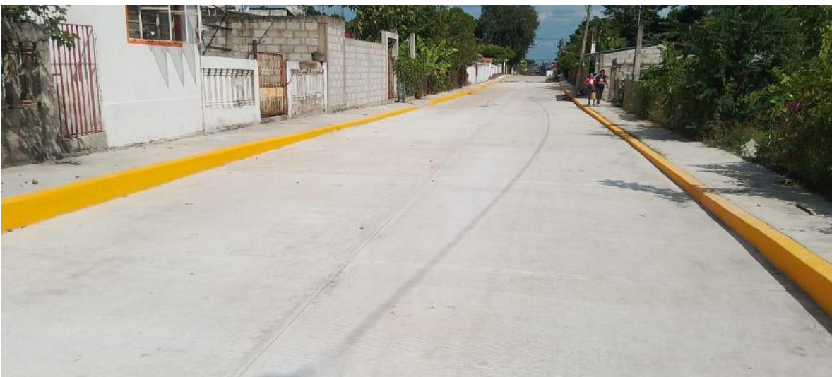
FOTO 2. CALLES PAVIMENTADAS CON CONCRETO HIDRAULICO.
